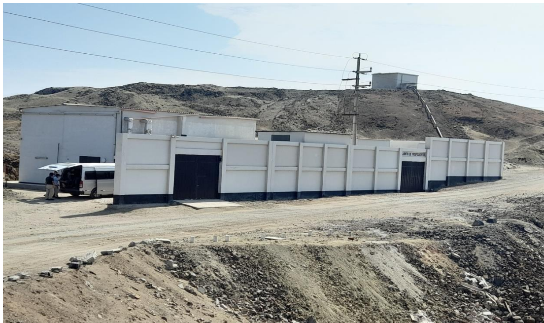
ITEM 01: MANTENIMIENTO CORRECTIVO DE PUERTAS METÁLICAS.
